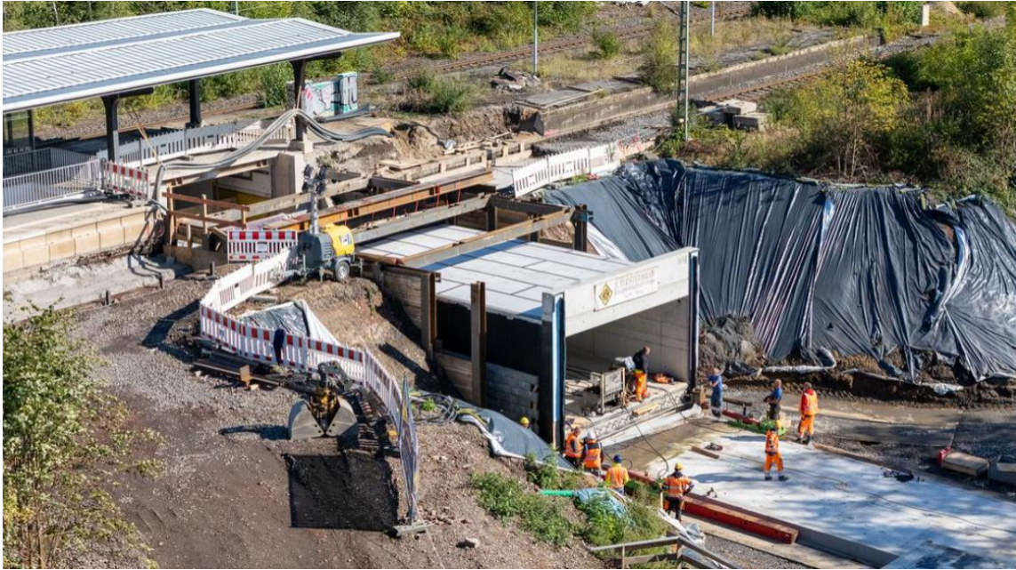
Abbildung 9 Baumaßnahme Personentunnelverlängerung Bahnhof Wattenscheid
